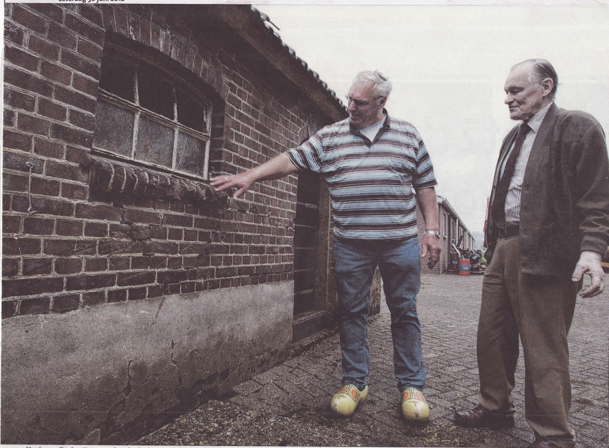
Henk van Beek wijst naar de schade die een tank in 1945 veroorzaakte aan de schuur van boerderij Gelkenhorst aan de Valkseweg. Rechts Gert Jan van Elten.
